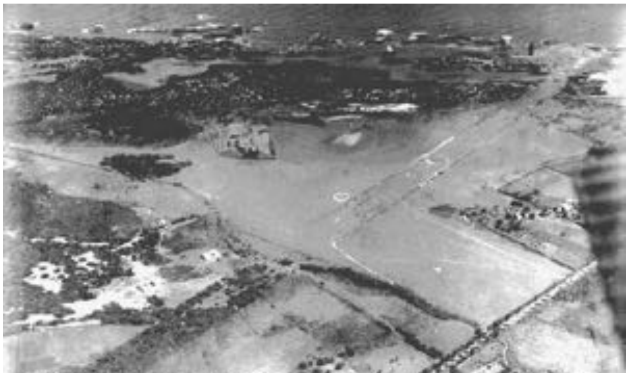
L'aérodrome de Djidjelli en juin 1932, lors de sa construction. La piste initiale est perpendiculaire à la piste 09/27 (qui sera construite par la suite - Eugène Fauché)
