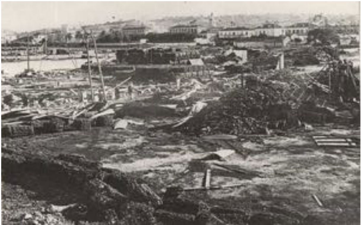
Dégâts du cyclone dans le port de DJIDJELLI (photo issue du site S. GRANGER)
