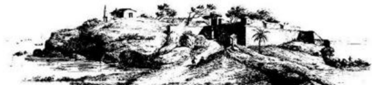
Le fort DUQUESNE à DJIDJELLI
